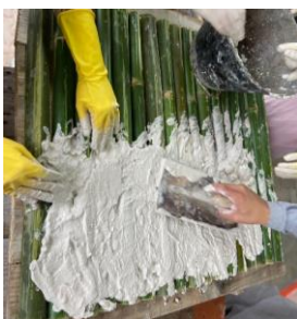
Figura 9: Aplicação da argamassa de estuque. Fonte: Acervo pessoal das autoras.
