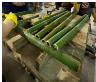
Figura 8: Colocação do fasquiado de taquara. Fonte: Acervo pessoal das autoras.
