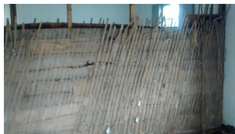
Figura 4: Divisória interna de tabique com estuque removido.
