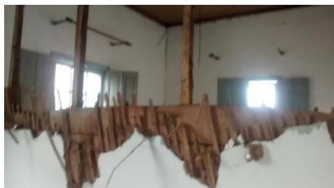
Figura 3: Divisória removida de tabique com estuque.
